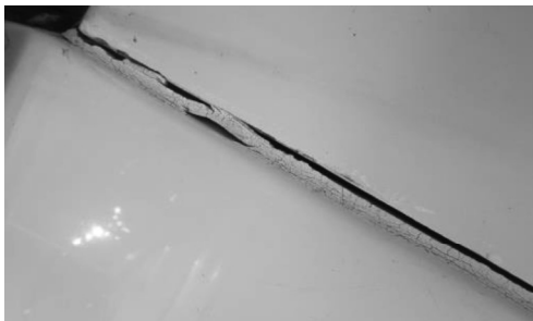
Entre la coque et la plateforme
